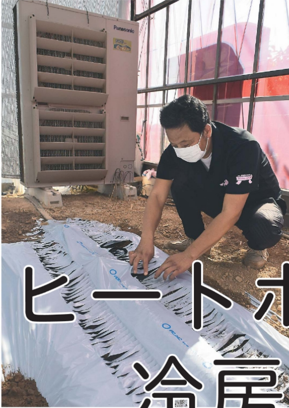
小久保さんのハウスでは、ヒートポンプ（奥）は芽が出始める9月下旬から稼働を始める（愛知県田原市で）
