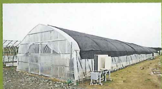
▲オール電化システムのため、空調機は4セットが分散配置されている。
