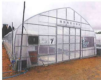
▼ヒートポンプの他、パッシブ型地中熱交換システムの実証も行っている。
