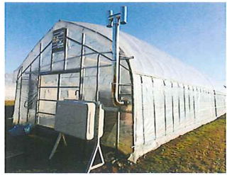
▲2重ビニールによる断熱性向上のための 実証試験
