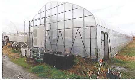
▲室外機の設置状況。灯油ボイラー併設のため油タンクの姿も。
