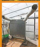
▲ハウスの末端に設置した室内機でハウス全体に送風。
