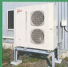
▲水蓄熱式HPを導入し北海道電力の割引メニューを適用。
