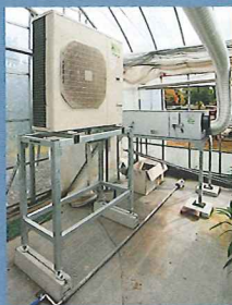
▲既存の灯油ボイラーを生かしたハイブリッド設置。
