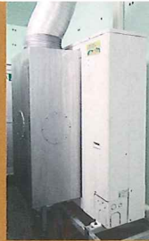
◀室内機はダクト方式に改造。
