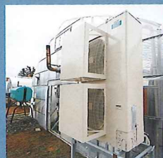
▲既存の灯油ボイラーを生かしたハイブリッド設置。
