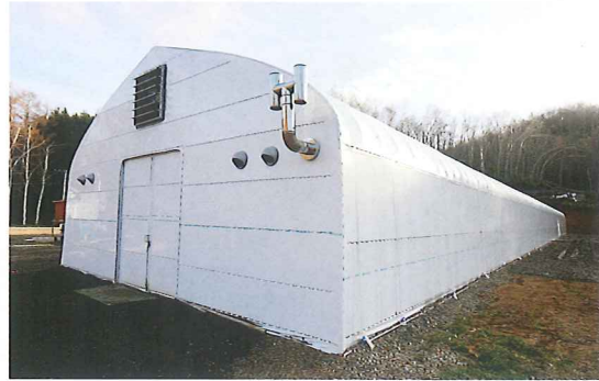
▲しいたけ栽培に光は不要なためハウスは遮光。 煙突は補助ボイラー用。
