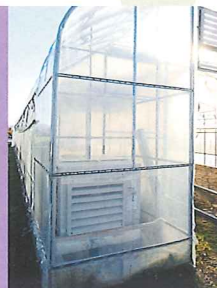
◀ 室外機はハウス内/ハウス外とセッティングを変えてデータ分析中。
