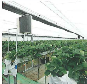
▲室内機は100坪ハウスに2機を分散配置。
